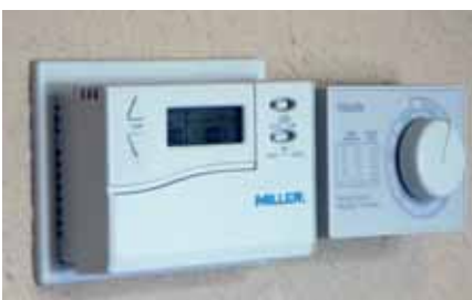
Rys. 6. Integralną częścią systemu HVAC jest sterownik Miller, który kontroluje pracę systemu
