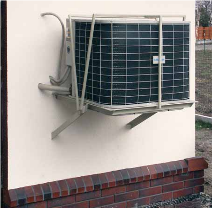
Rys. 5. W przypadku funkcji chłodzenia odpowiedniej mocy klimatyzator, montowany na zewnątrz budynku, współpracuje z kanałową chłodnicą umieszczoną na nagrzewnicy
